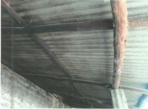
Foto1: Mejoramiento con estructura tipo pórtico y lámina troquelada calibre 26 en la cocina.
