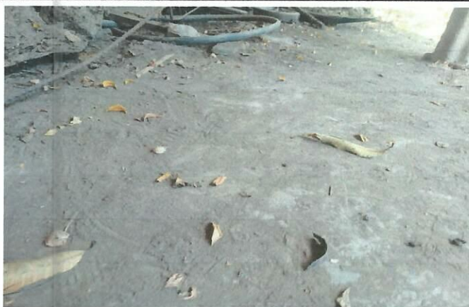
Foto 3: Instalación de piso concreto en la cocina
